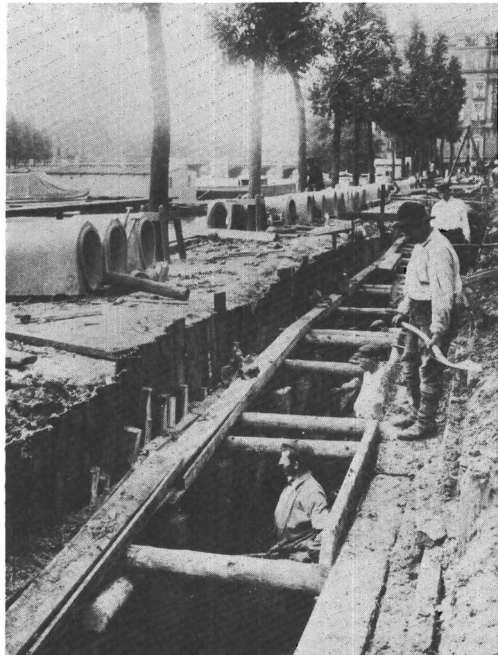
Aanleg van riolering, Amsterdam 1914.
