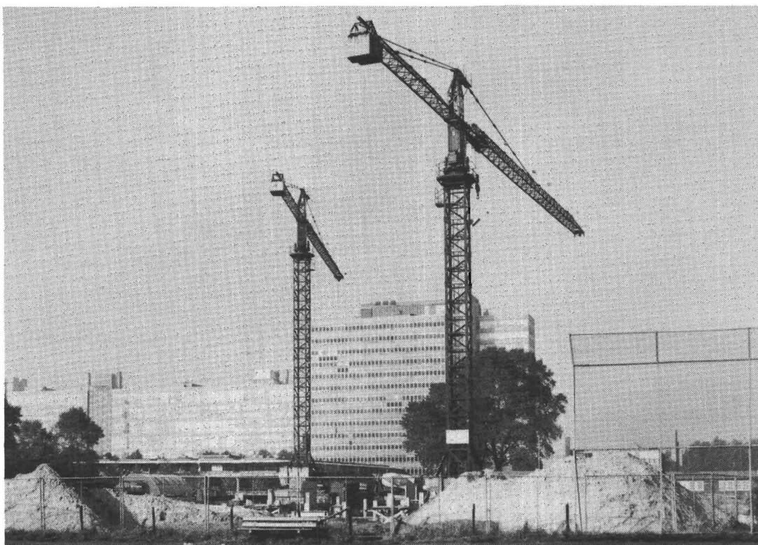
De nieuwbouw (NLO, IPO en bestuursgebouw) vordert een voorspoedig. De werkzaamheden vorderen precies volgens het schema van de Bouw Technische Dienst. De aannemer heeft zelfs het schema in gunstige zin bijgesteld. Twee reuzenkransen bepalen momenteel het beeld op het bouwterrein.
