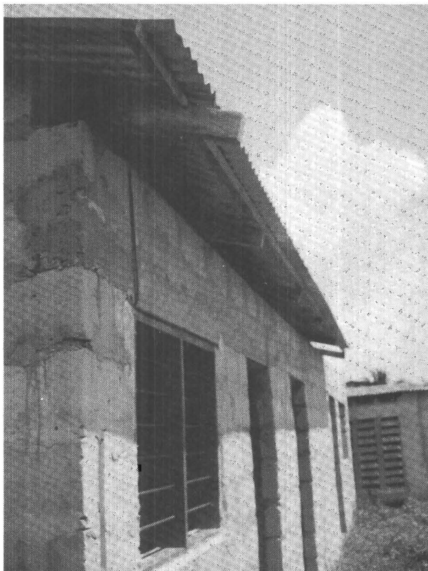
Voorbeeld van small scale woningbouw: de stenen zijn gemaakt van cementzand en de dakbedekking bestaat uit golfplaten.
