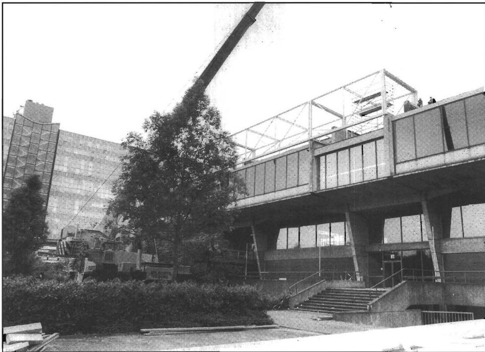
De afgelopen dagen zijn op de zijanten van het auditorium de geraamtes voor de nieuwe, aluminium luchtbehandelingskokers aangebracht, ter vervanging van de gedemonteerde Verolme-kokers. De machinekamers, die vroeger apart stonden, worden ook hierin opgenomen. Foto: Hans van der Burgt/RF
