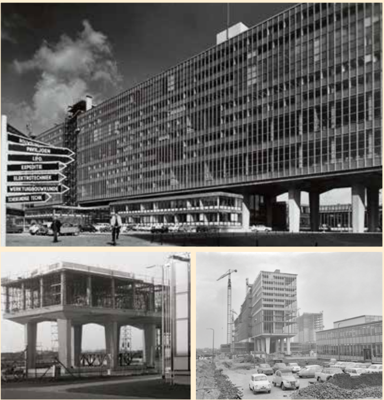
Bouw van het TU/e Hoofdgebouw, nu Atlas, circa 1962. Construction of the TU/e Main Building, now Atlas, circa 1962.
